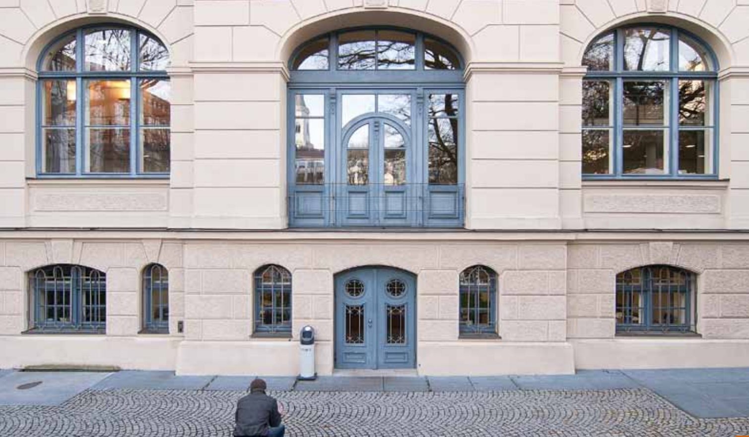
▲ Fassade des Historicums im Salinenhof
