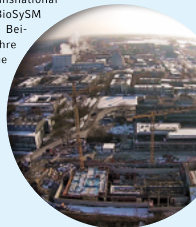
▲ Baustelle des CALA in Garching
