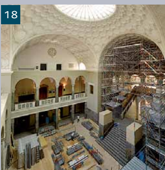
HAUPTGEBÄUDE- SANIERUNG DER LICHTHOF IN NEUEM GLANZ
