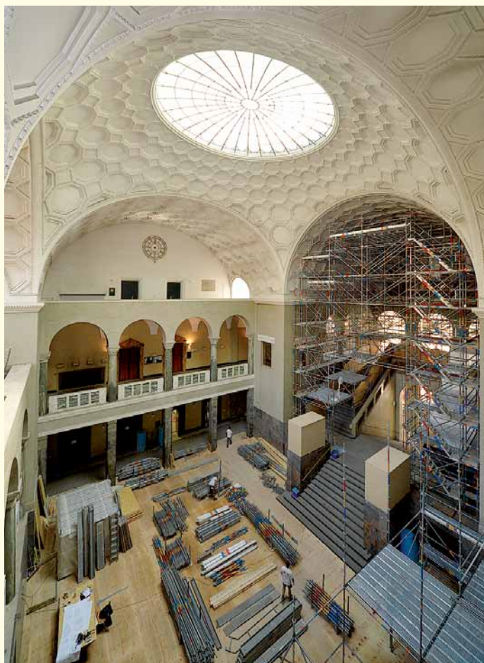
▲ Mit dem 25 Meter hohen Spezialgerüst werden die Glaselemente der Außen- und Innenkuppel im Lichtturm ausgewechselt.
