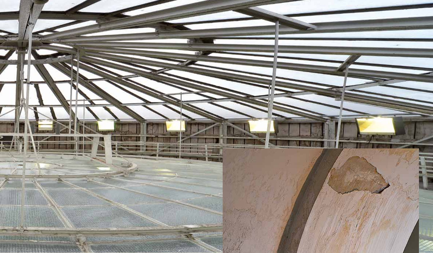
▲ Der Putz bröckelt bereits und die Glaskuppel ist nicht mehr dicht.
