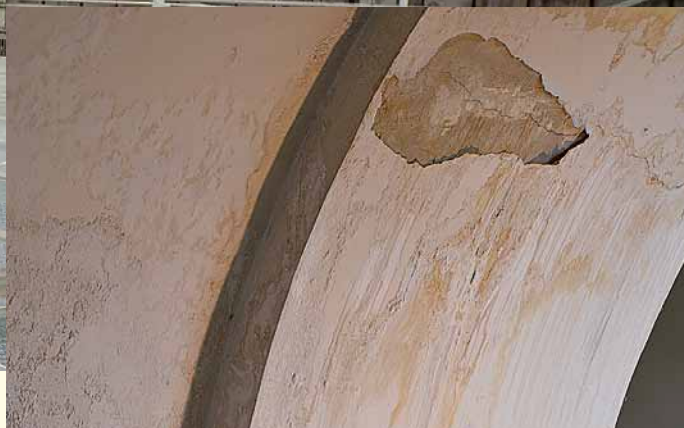
▲ Der Putz bröckelt bereits und die Glaskuppel ist nicht mehr dicht.
