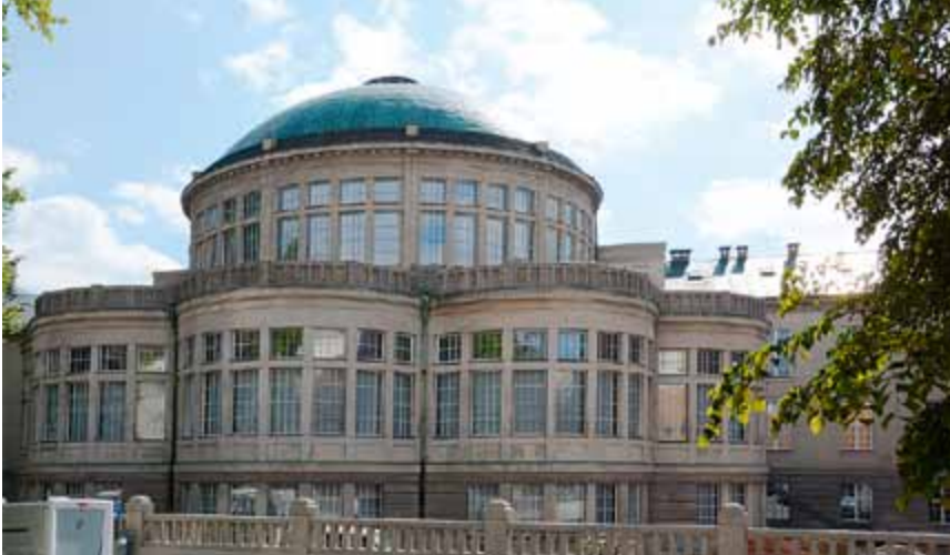
▲ Die sanierte Fassade der Anatomischen Anstalt in der Pettenkoferstraße
